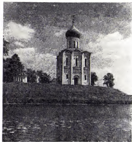
Церковь Покрова на Нерли. 1165. Общий вид.
